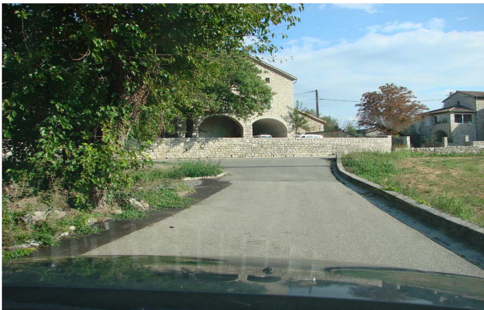
Débouché de l'itinéraire de déviation sur la RD 201 à l'ouest du village de Berrias
